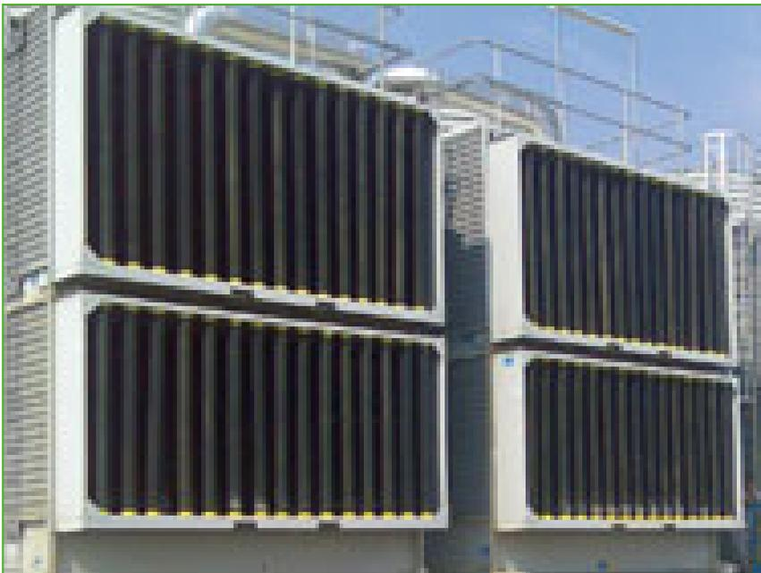
FXVT-Kühltürme mit geschlossenem Kreislauf verwenden **leise und leistungsarme Axiallüfter**, um aber die Geräusentwicklung noch weiter zu verringern, können Sie Ihre FXVT-Kühltürme mit geschlossenem Kreislauf durch Schalldämpfung erweitern:
