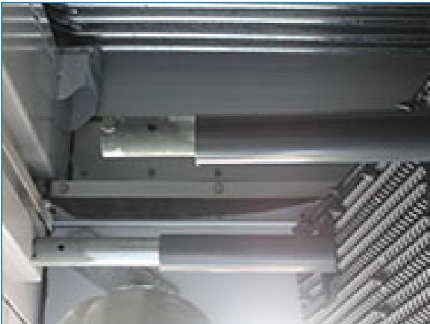
Die Verwendung des Teleskop-Füllkörperträgers erleichtert das Entfernen und den Austausch von Füllkörperblättern.
