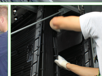
Relleno BACross patentado para limpieza e inspección
