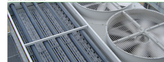
Pleno acceso a la distribución de pulverización y a la parte superior de la batería durante el funcionamiento
