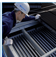
обслуживание на объекте
