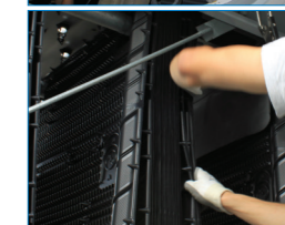
Pacco di scambio BACross II brevettato per ispezione e pulizia foglio per foglio
