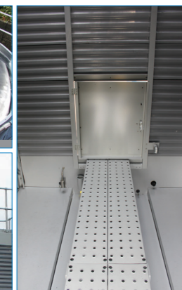
Portello d'ispezione apribile verso l'interno e passerella interna*
