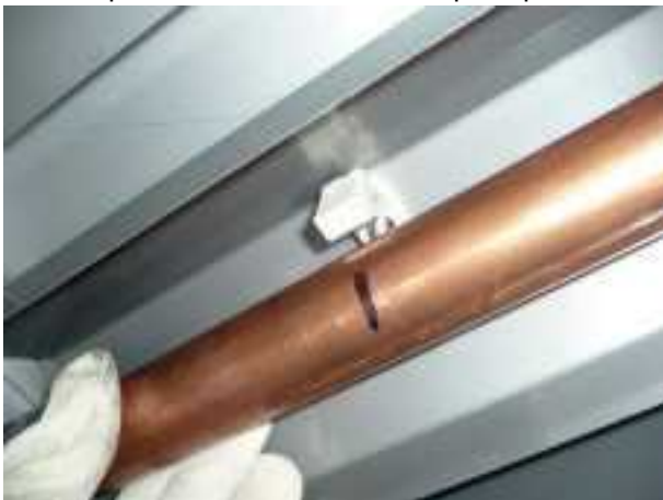
Совмещение трубы подачи воды
