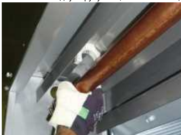
Высвобождение медного коллектора из пластиковых держателей
