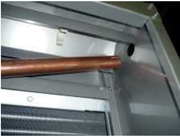
Установка медной трубы подачи воды
