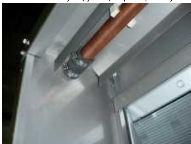
Соединение гибкого рукава с хомутами
