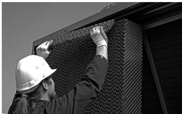
Извлечение водораспределительных панелей
