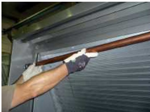
Извлечение медной трубы подачи воды
