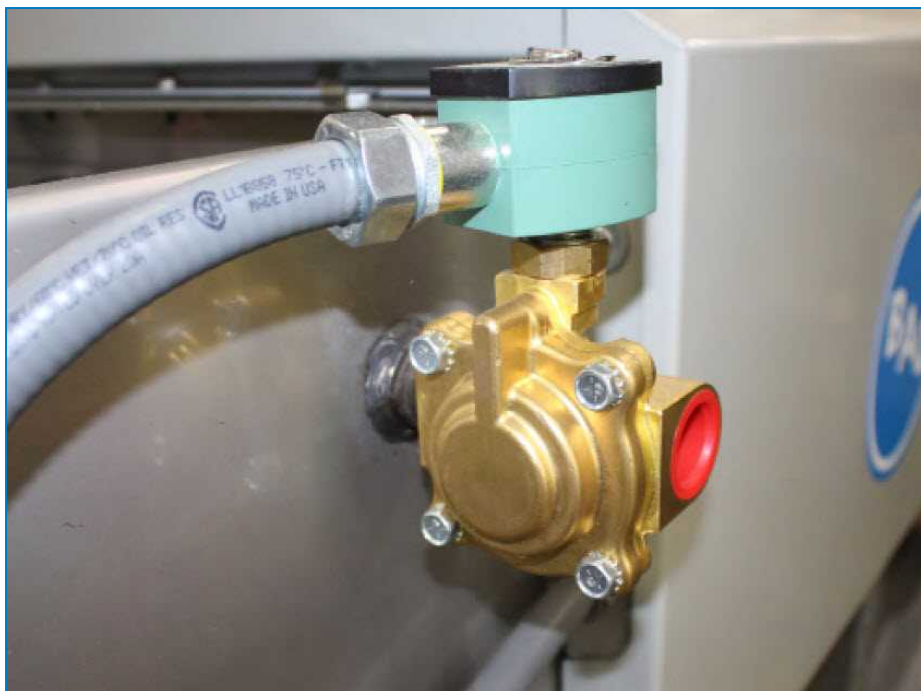
Valvole a solenoide di drenaggio
