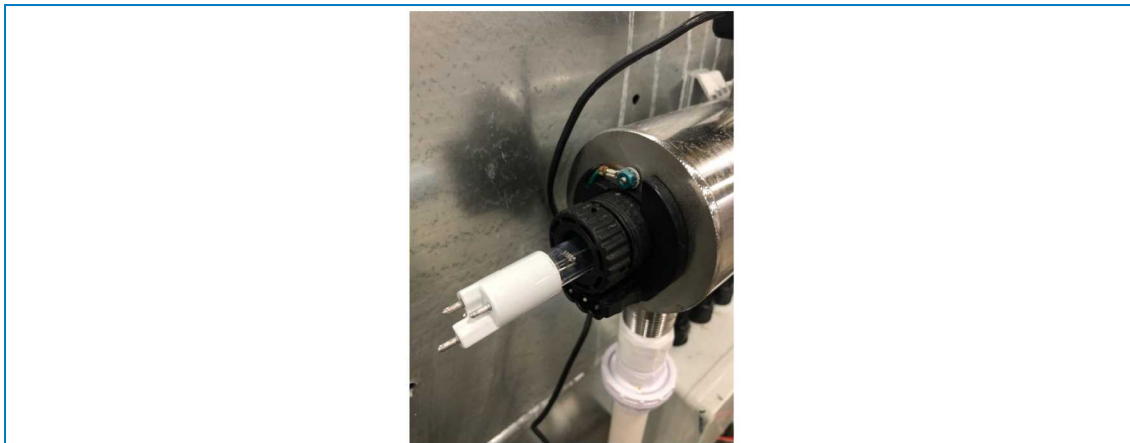
Estrazione della lampada UV
