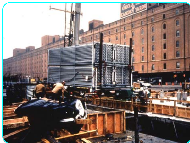
Batteries installées dans un réservoir en béton
