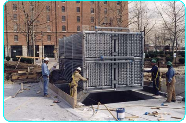
Installation d'un module batteries
